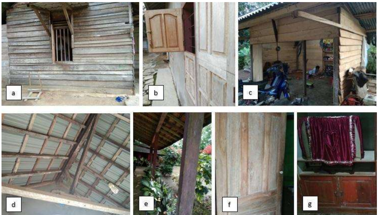
Gambar 2. Pemanfaatan tumbuhan sebagai bahan bangunan di Desa Pulung Rejo (a) Dinding bangunan, (b) jendela, (c) bahan konstruksi bengkel, (d) penyangga, usuk, dan reng, (e) tiang, (f) pintu, (g) perkakas rumah tangga (Dokumentasi Pribadi, 2021)
